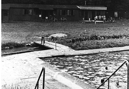
Koupaliště v Podhohli je věcí, kterou můžeme našim předkům závidět. Stavba si tehdy v 50. letech vyžádala ohromné zapojení dobrovolných prací.
