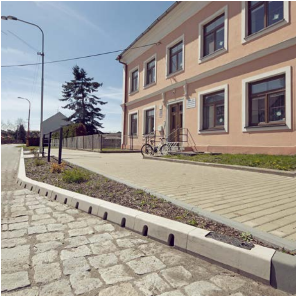
BETONOVÝ OBRUBNÍK S BOČNÍ VPUSTÍ nahrazuje původní betonový žlab v centru obce s podobnou kapacitou odvodu dešťové vody.
