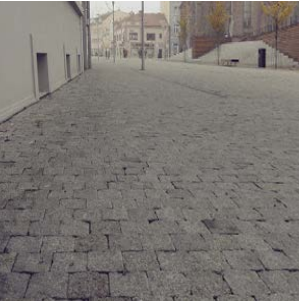
CHODNÍK žulové kostky 10/10/8cm štípané s tryskaným lícem, kladené rovně, kolmo k silnici. Ohraničuje je žulový obrubník. Kostky navazují na historickou dlažbu, která v obci byla a zároveň na rekonstruované chodníky u parku. Tryskaný líc umožňuje pohodlnou chůzi.
