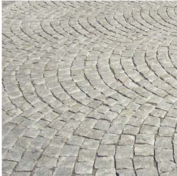
MANIPULAČNÍ PLOCHA HASIČSKÉ ZBROJNICE žulové kostky 15/17cm kladené do vějíře. Tradiční skladba pro plochy určené autům je velmi únosná a v případě poruchy lehce opravitelná.
